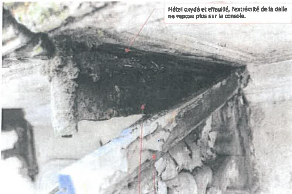
Métal oxydé et effeuillé, l'extrémité de la dalle ne repose plus sur la console.
