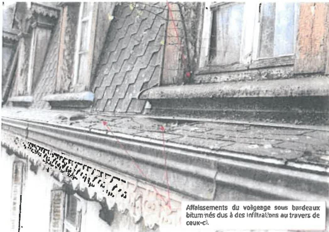
Affaissements du voilage sous bardeaux bitumés dus à des infiltrations au travers de ceux-ci.
